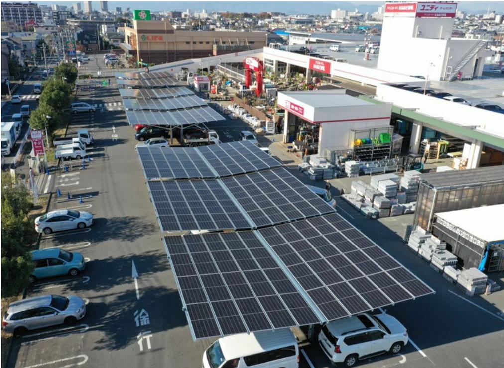
ユニディ相模大野店（神奈川県相模原市南区）の駐車場に、出力 201.6kW のソーラーカーポート 64 台分を設置し 2024 年 12 月 13 日より運転を開始致しました。想定自家消費量は年間 203,206kWh\*<sup>1</sup>、91.6t\*<sup>2</sup>の CO2 排出量を削減する見通しです。
